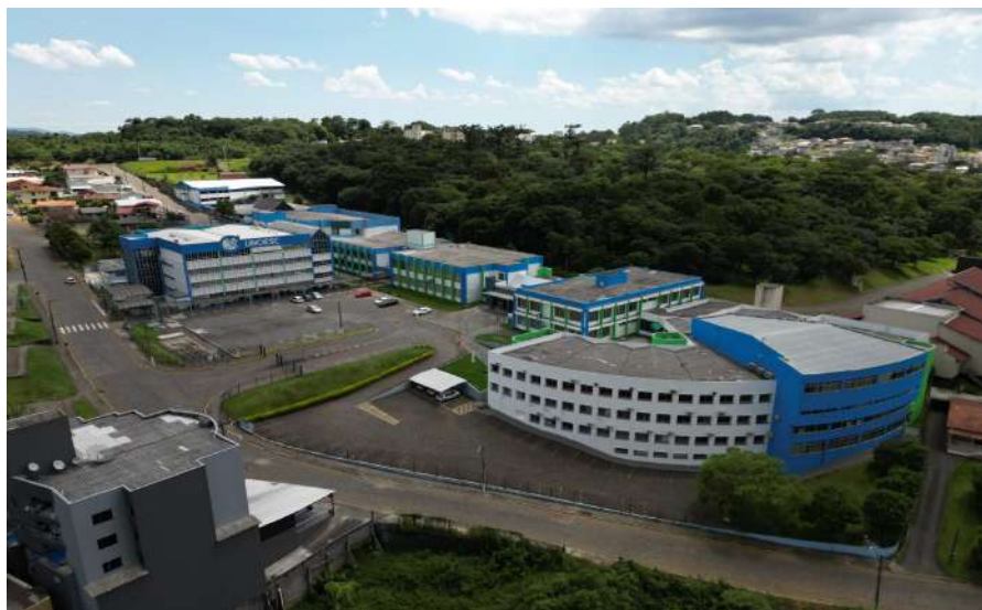
Fotografia 11 – Vista aérea das estruturas físicas da Unoesc Videira
