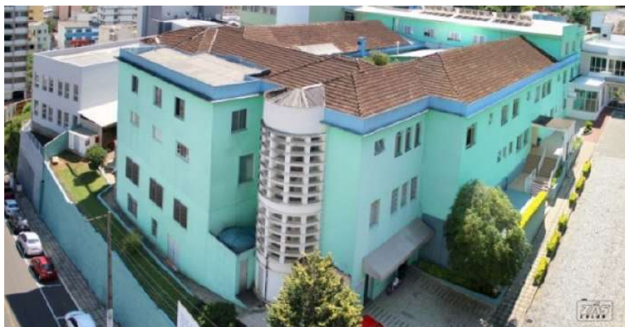
Fotografia 12 – Parte das instalações do HUST
