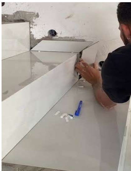
Figura 1: Execução de porcelanato e rodapé.
