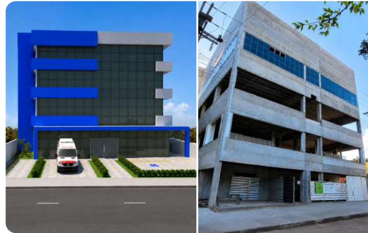
Fotos: projeto | Fachada externa, Fase da obra.
