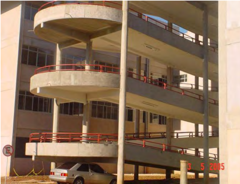
Construção Bloco VII (2005)
