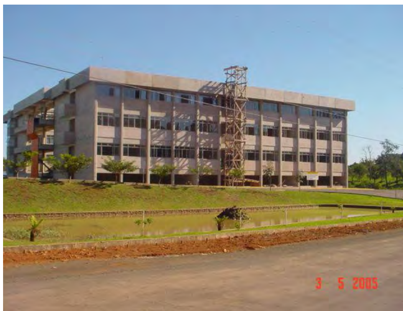
Construção Bloco VII (2005)
