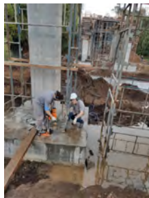
Extração de testemunho de concreto em ponte (2019)
