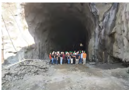
Visita obras PCH Ipira (IX Simpósio das Engenharías e Arquitetura)
