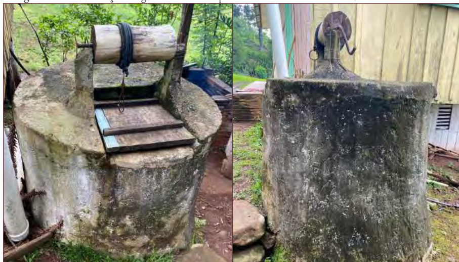
Fotografias 10 e 11 - Poço de água construído aproximadamente no ano de 1970
