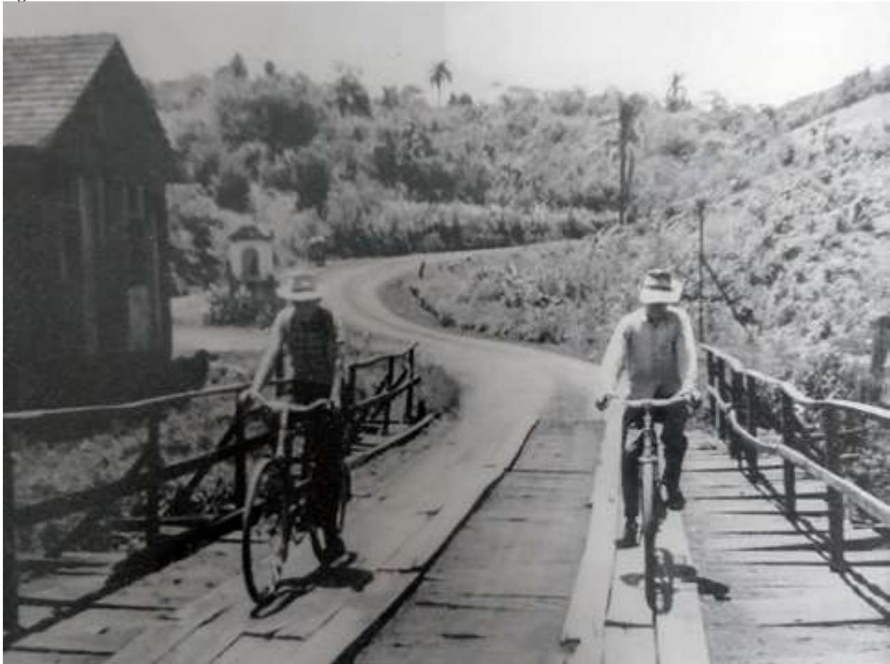
Figura 21 – Ponte sob o rio Leãozinho
