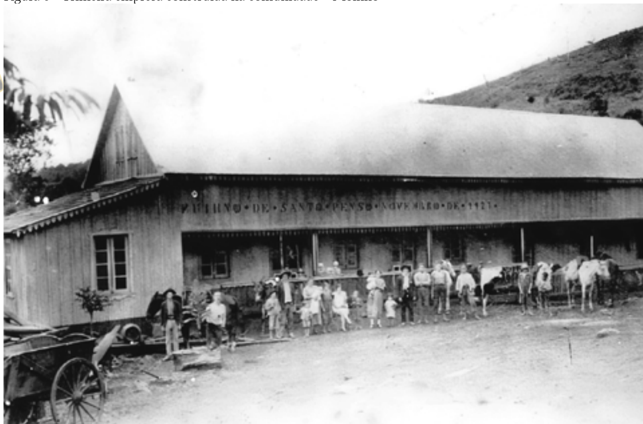
Figura 6 – Primeira empresa construída na comunidade – Moinho
