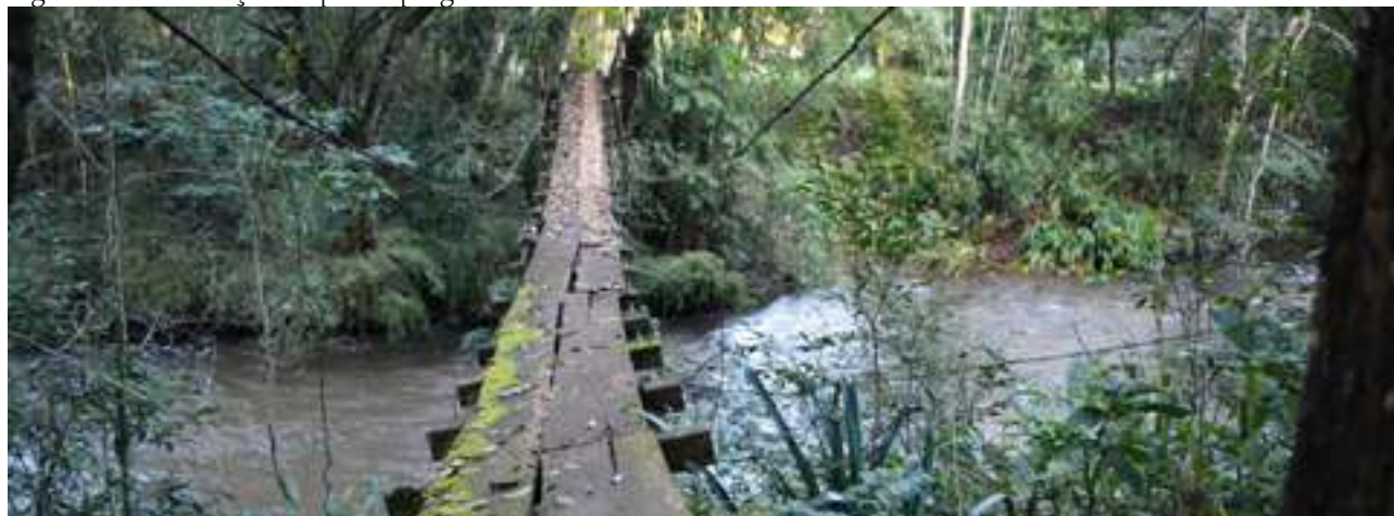
Figura 8 –Construção de ponte pinguela na comunidade
