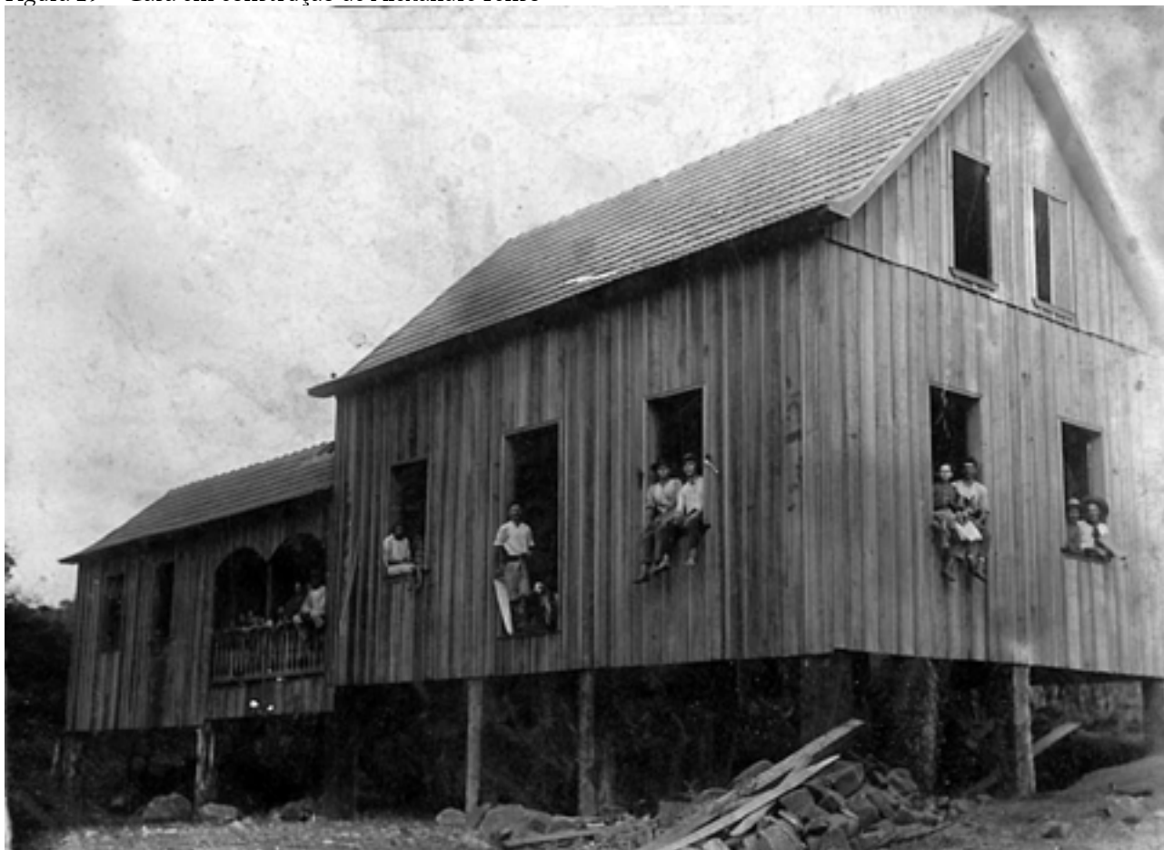
Figura 29 – Casa em construção de Alexandre Penso
