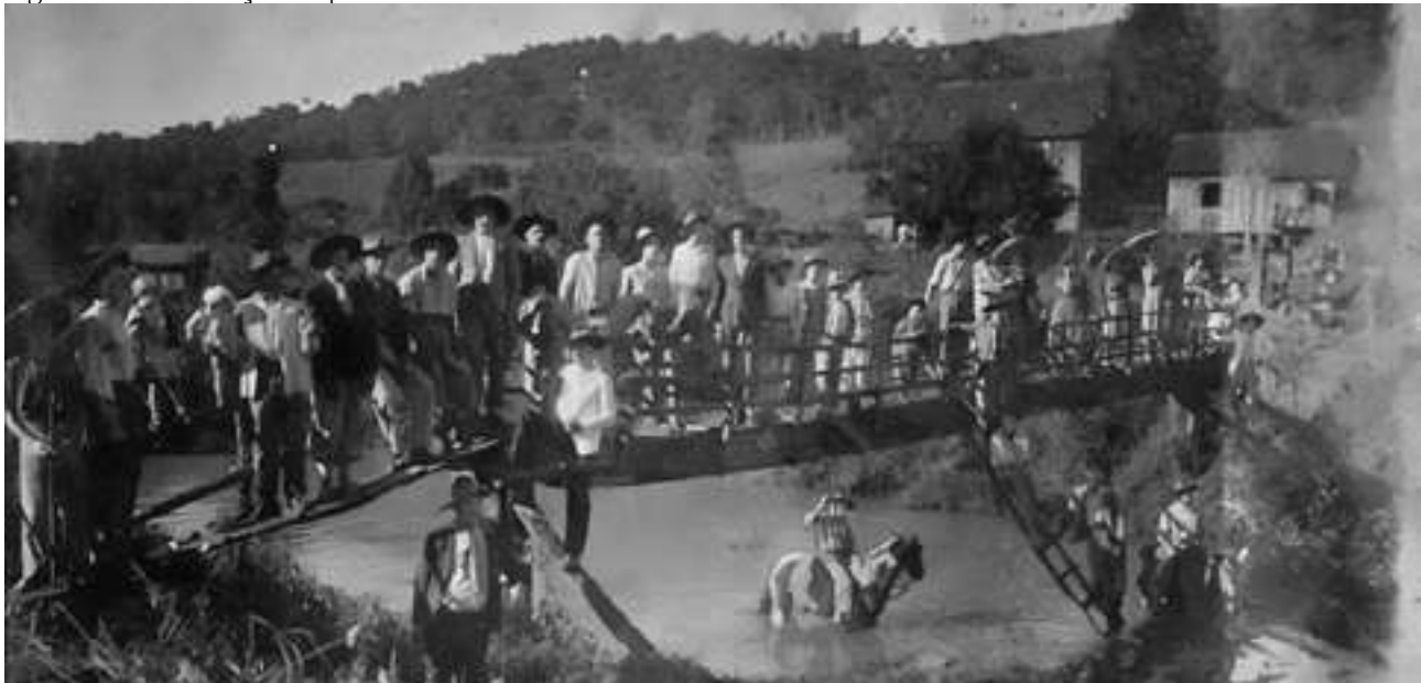
Figura 7 – Construção de ponte na comunidade
