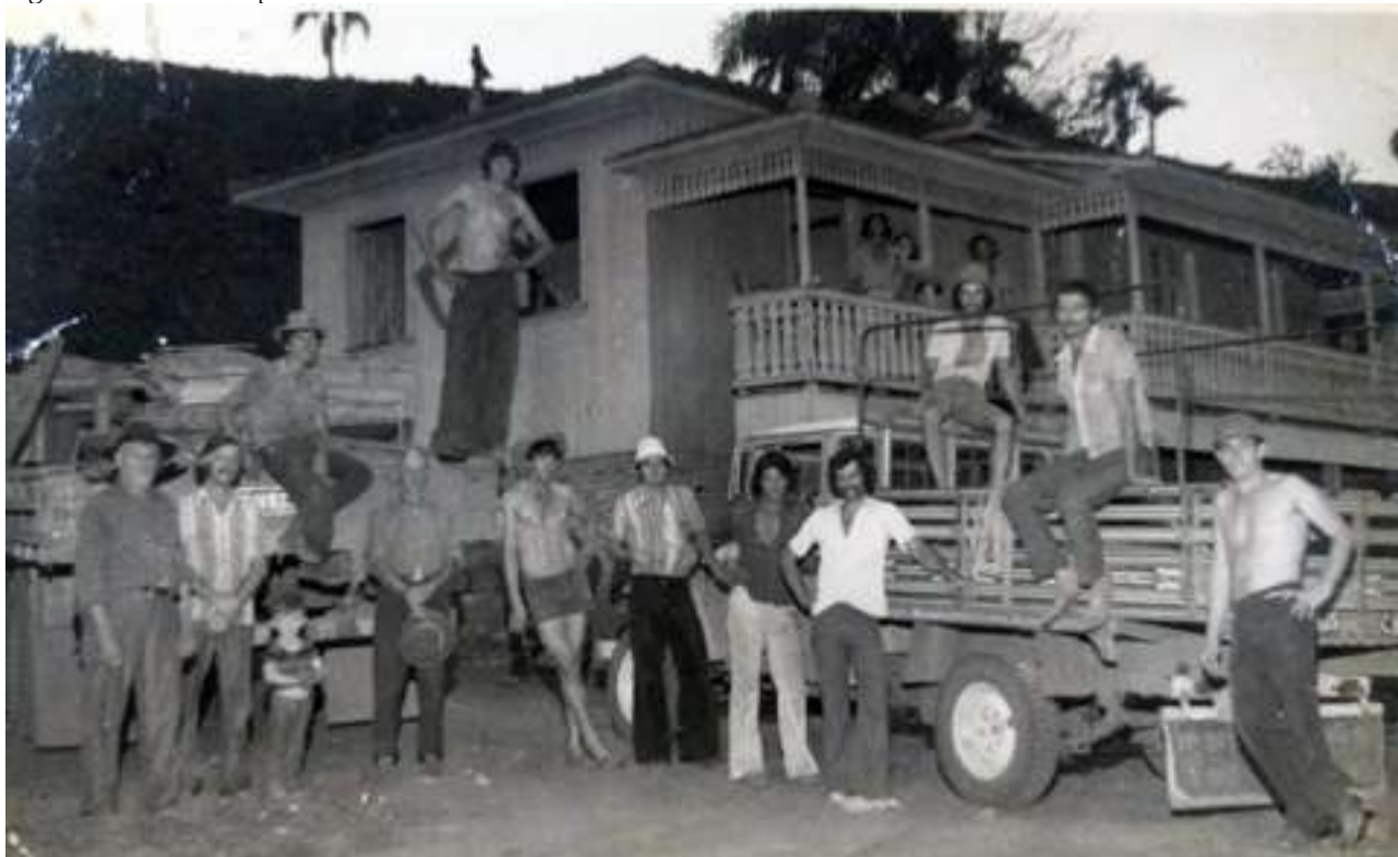
Figura 92 – Pessoas que instalaram a rede elétrica na comunidade
