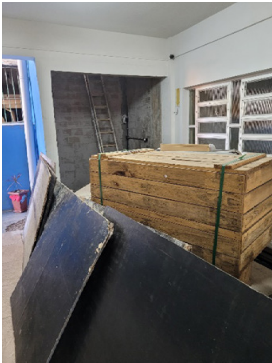
Figura 8 – Instalação de um elevador
