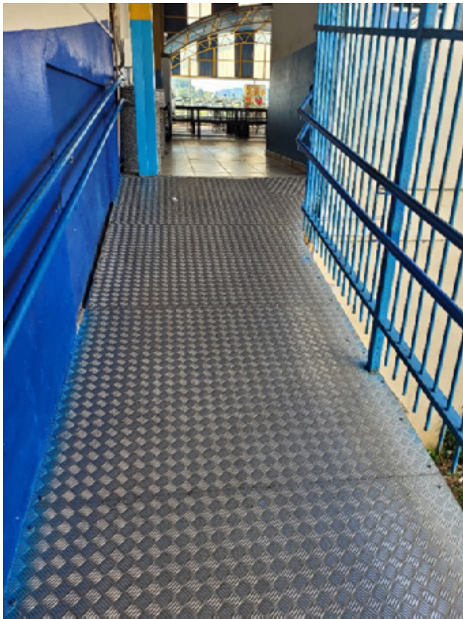
Figura 5 – Rampa de acesso ao refeitório
