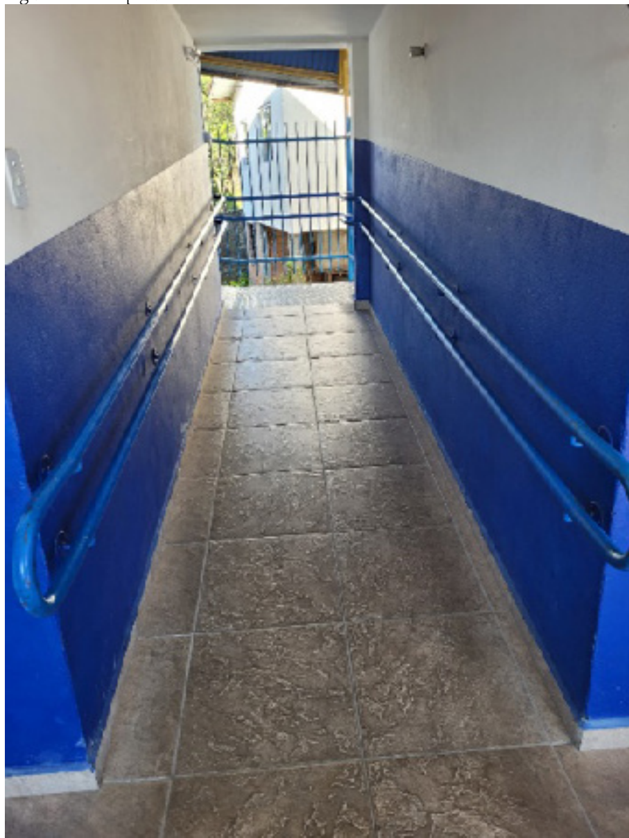
Figura 6 – Rampa de acesso ao refeitório
