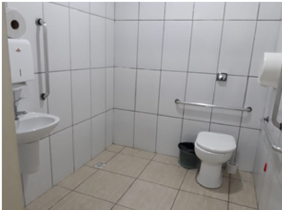
Figura 28 - Banheiro adaptado, no segundo andar, da construção principal da escola
