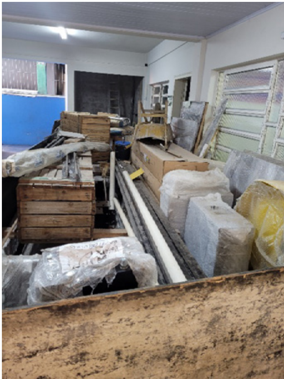
Figura 7 – Instalação de um elevador
