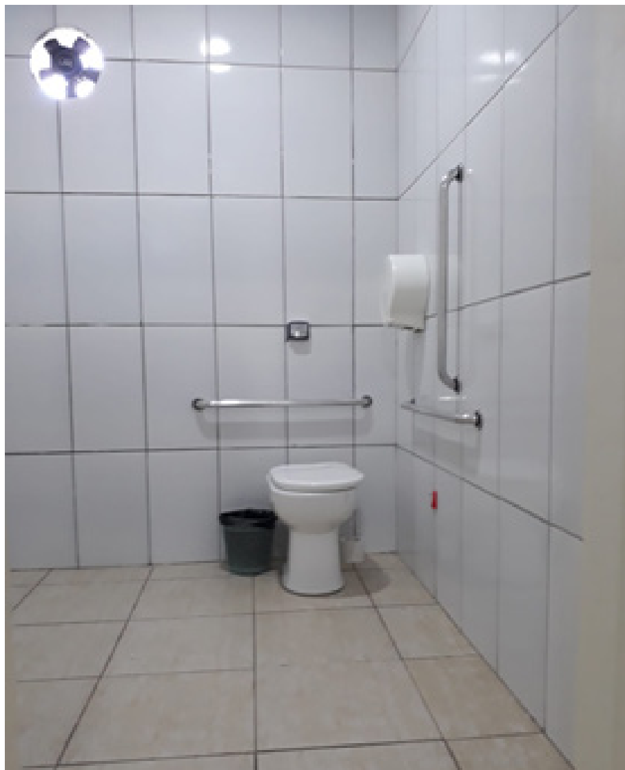
Figura 27 - Banheiro adaptado, no segundo andar, da construção principal da escola
